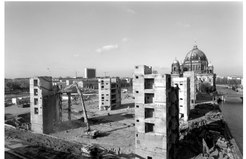
Blick auf die Abrissarbeiten des Palastes der Republik, rechts der Berliner Dom und die Spree (2008).
