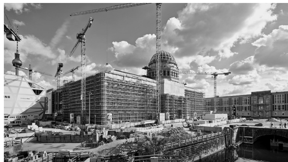
Baustelle des Humboldt Forums auf dem Schlossplatz Berlin, im Hintergrund rechts das ehemalige Staatsratsgebäude der DDR (2015).
