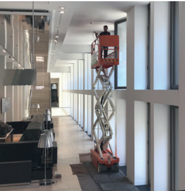
Wartungsarbeiten an den Fenstern im 1. Geschoss der Treppenhalle
