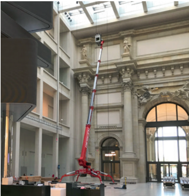
Wartungsarbeiten an der Entrauchungs-anlage im Foyer des Humboldt Forums
