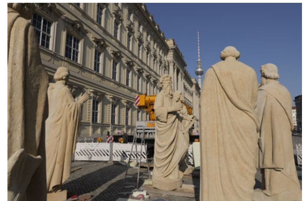
Baumaßnahmen an Portal 5, Reinigung von Kunstgut – keramische Wandgestaltung aus dem Palastrestaurant im Palast der Republik, Aufstellung der acht Propheten-Skulpturen für die Kuppel-Balustrade
