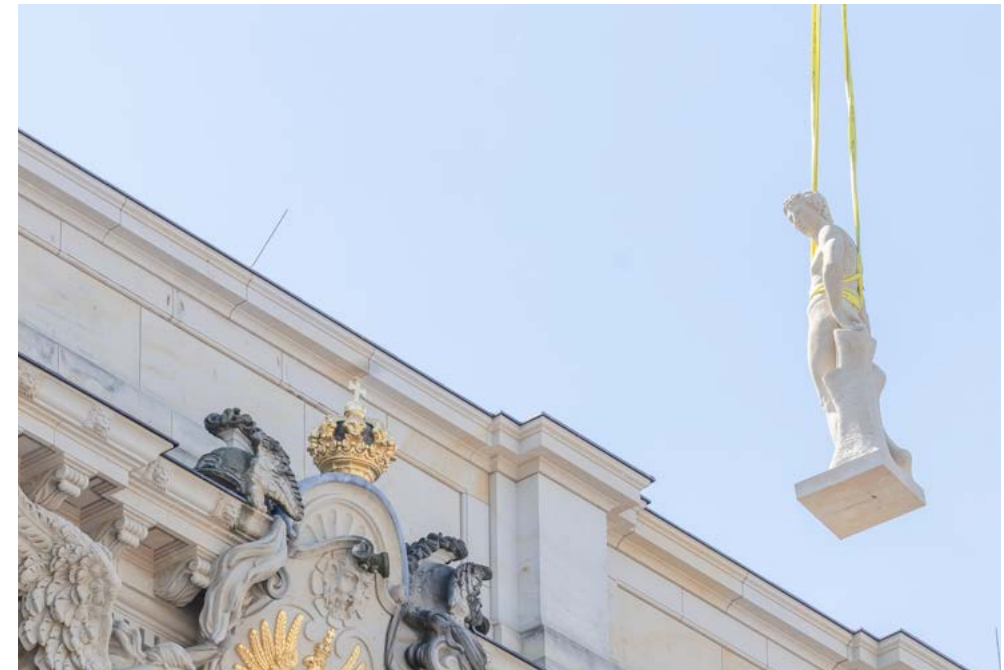
Letzte Baumaßnahmen: Anlieferung und Aufstellen der 19 Balustradenfiguren
